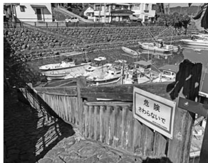
手結内港斜道
