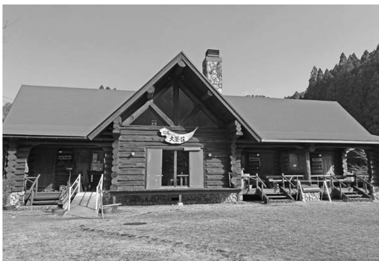
羽尾林業活動活性化センター
