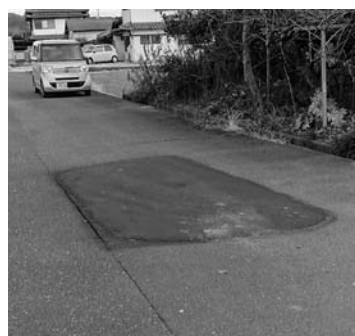
路面の陥没の補修箇所(野市町内)
