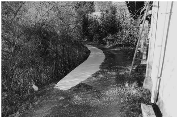
修繕された道路
