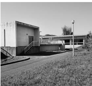
野市浄化センター
