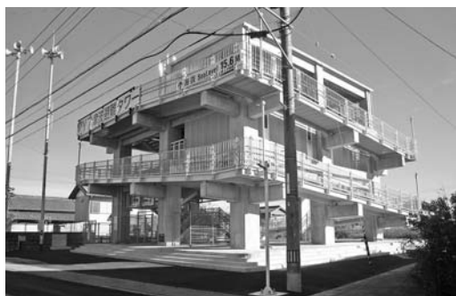
錦地区の避難タワー
