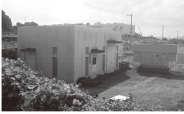
和田橋水源地
