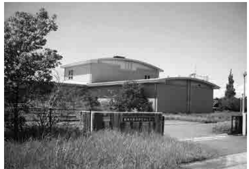
野市浄化センター
