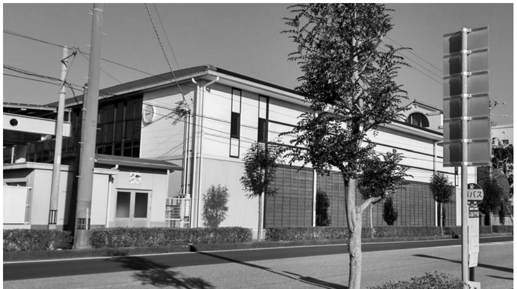
野市小学校体育館
