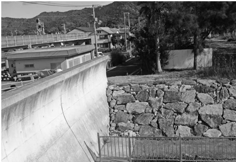
ヤ・シパーク開発で撤去された防潮堤
