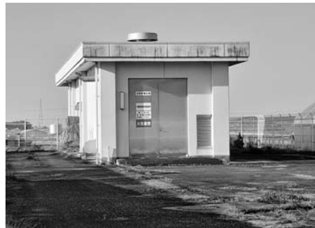
野市町第一水源地
