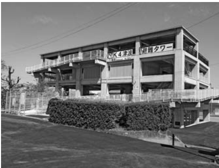
岸本津波避難タワー
