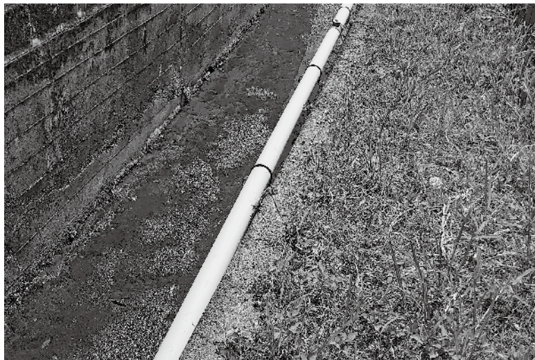
「原材料支給を活用した自治会による里道・水路の改修例 改修前」
