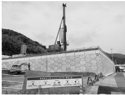
工事中の夜須防災コミュニティセンター
