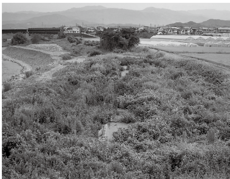
農業集落排水処理施設の附帯施設
