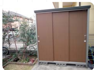
地面に固定していない
