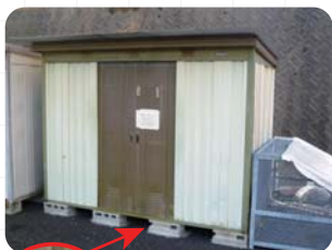
地面に固定している
