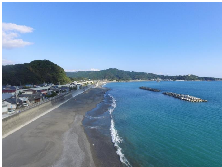
写真 4 離岸堤の整備
