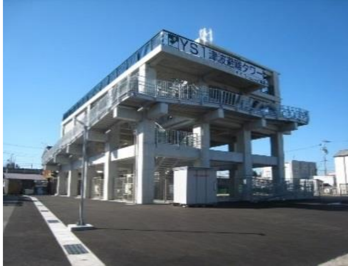
写真 5 津波避難場所（避難タワー）
