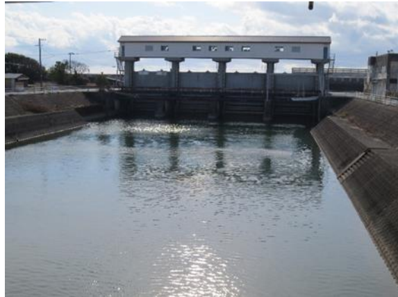
写真 3 放水路防潮水門の整備
