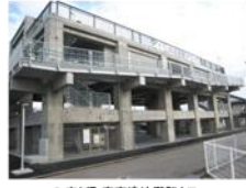
Y5 吉川町東南津波避難タワー
