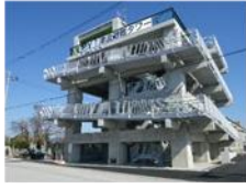
Y1 吉川町浜口南部津波避難タワー
