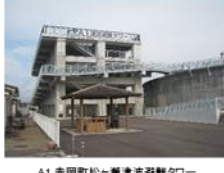
A1 赤回町松ヶ瀬津波避難タワー
