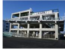
Y3 吉川町西北津波避難タワー
