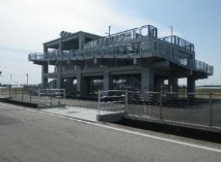
N1 野市町横井津波避難タワー
