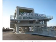
Y8 吉川町松ヶ瀬津波避難タワー
