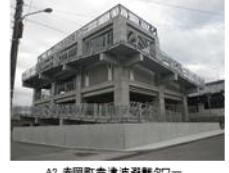
A2 赤回町幸津波避難タワー
