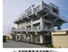
A3 赤回町東寛津波避難タワー
