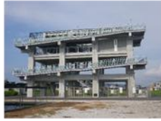
Y2 吉川町清水八反津波避難タワー
