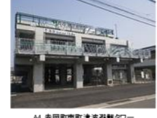
A4 赤回町南町津波避難タワー
