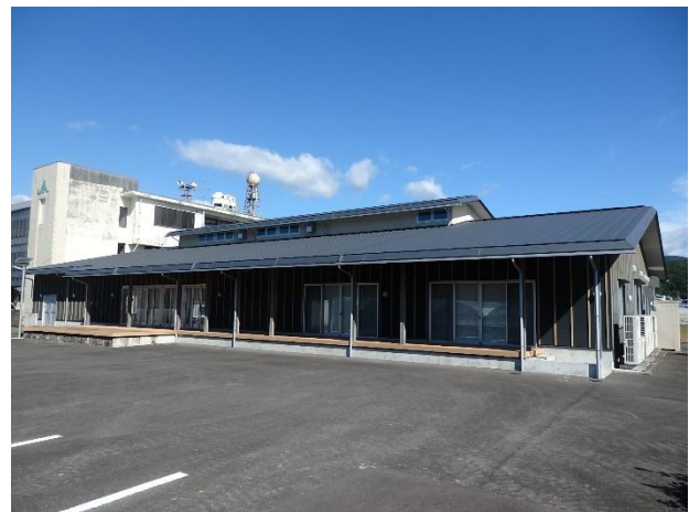
(No.8) 山南防災コミュニティセンター
