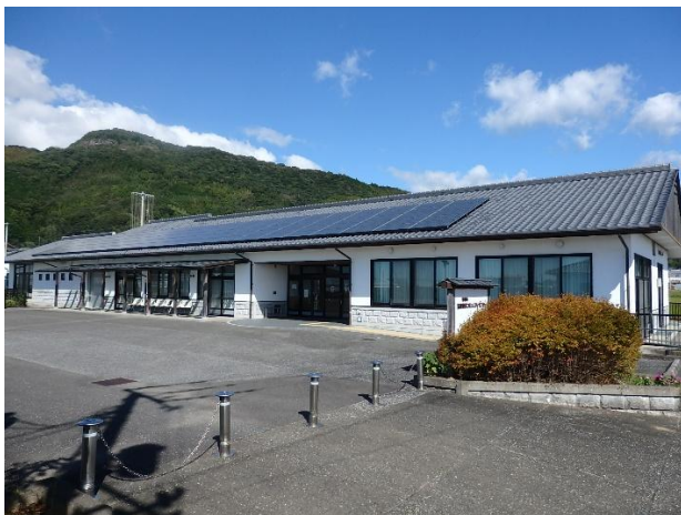
(No.7) 富家防災コミュニティセンター
