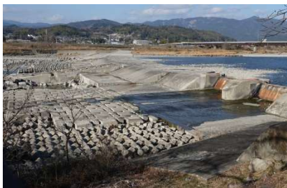
物部川の渇水の様子（物部川統合堰（町田堰））2019.3
