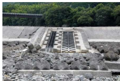
水が流れていない魚道
